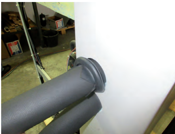
Anschlusschläuche mit fertig montierter Isolierung
