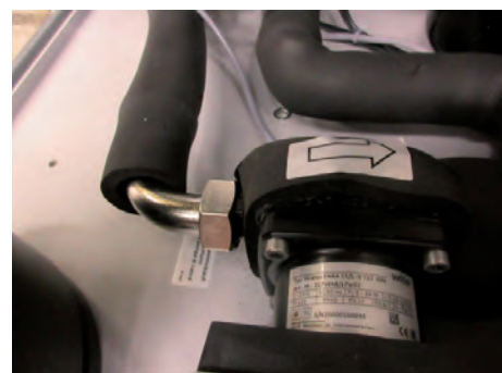
Anschluss Wärmepumpenrücklauf
