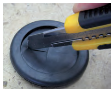
Einschneiden der Gummitüllen
