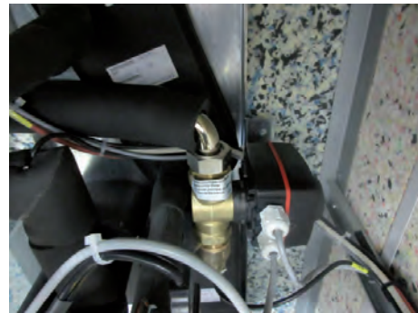
Anschluss Wärmepumpenvorlauf
