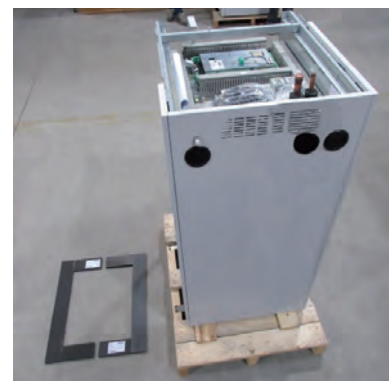
Platzierung Schalldämmunterlage
