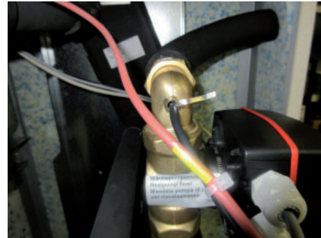
Anschluss Wärmepumpenvorlauf
