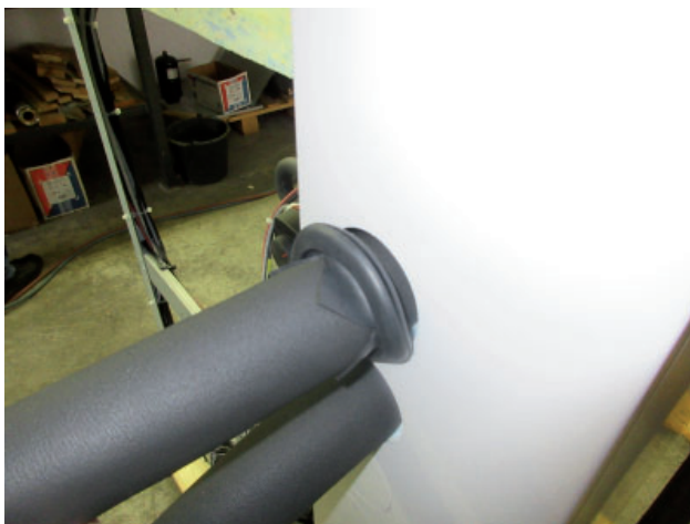
Anschlusschläuche mit fertig montierter Isolierung
