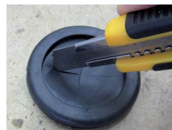
Einschneiden der Gummitüllen
