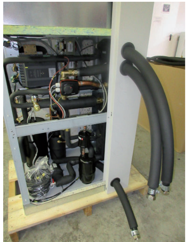
Fertig montierte Anschlusschläuche bei der AERO SLM 3-11
