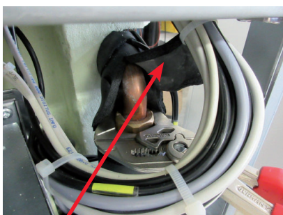
Armaflex-Isolierung
