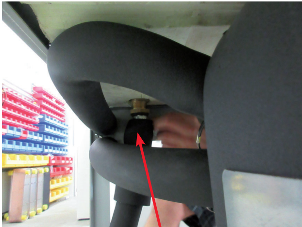
Armaflex-Isolierung
