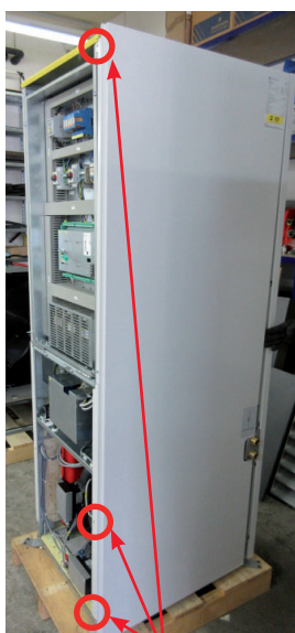
Befestigungsschrauben lösen
