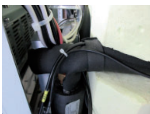
Wärmepumpenvorlauffühler B33
