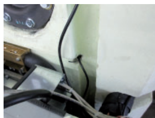
Trinkwassererwärmerfühler unten B41
